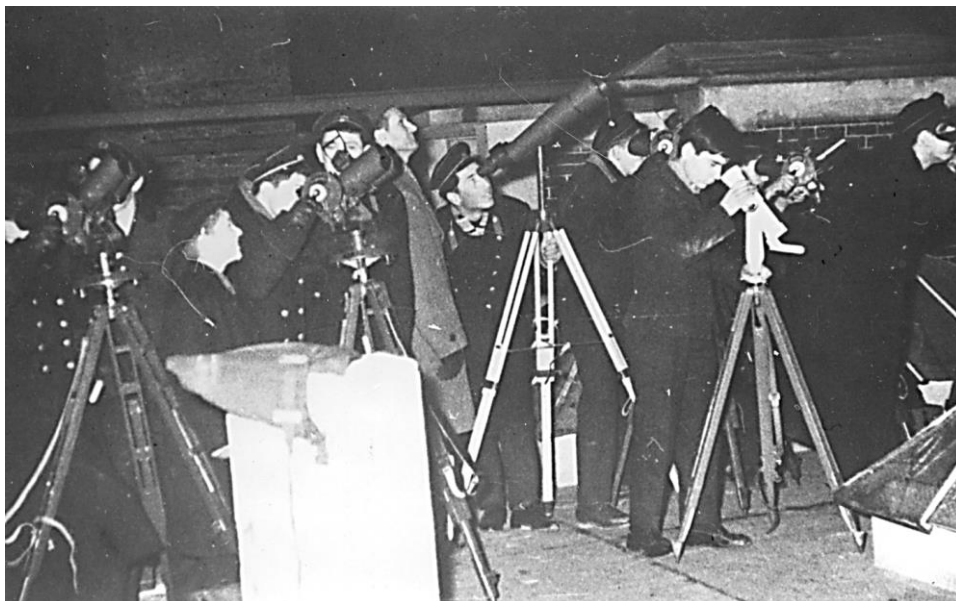
Рис. 1. Наблюдение за ИСЗ командой НАО, Стара Загора (1961 г., станция №1102) по методу оптических барьеров спутниковых траекторий
